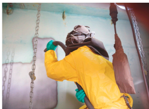
循環式プラスト工法施工状況
