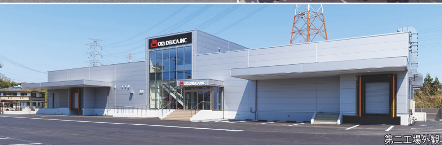
第二工場外観
