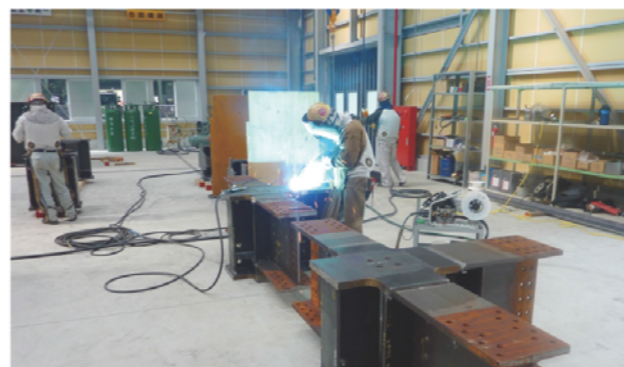
工場での溶接作業の様子
