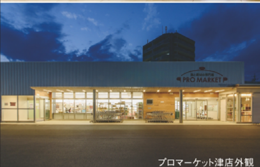
プロマーケット津店外観
