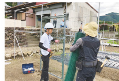
獣害ネットの設置
