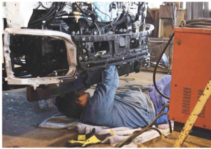
ヒーターのバルブ取付作業
