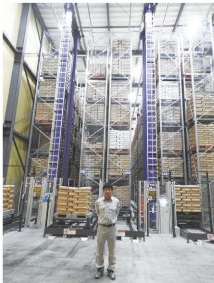
立体自動機械倉庫
