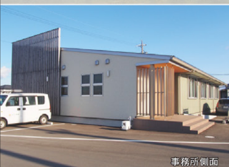
なかむら建設明和事務所外観
