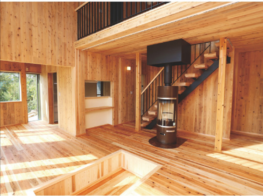
「伊勢の家」～CLTを使用した日本初の住宅～
