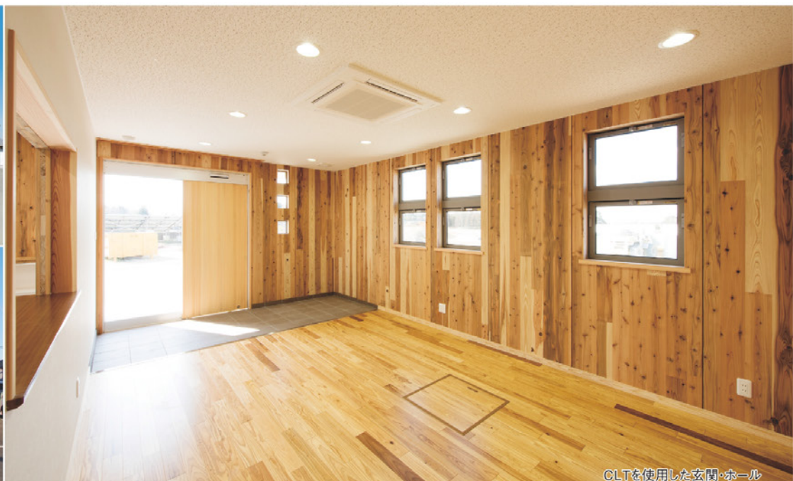
CLTを使用した玄関・ホール
